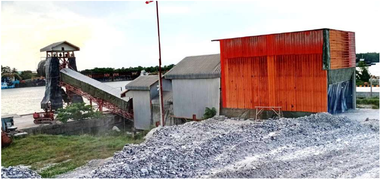
ภาพรวมระบบสายพานลำเลียงและอาคารโกรกเทลิสินค้าที่ปรับปรุงใหม่
