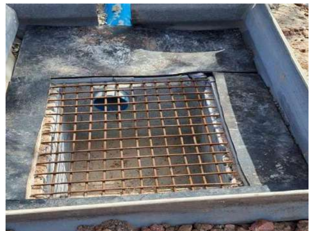
บ่อดกตะกอน (บ่อดกคอนกรีต)
