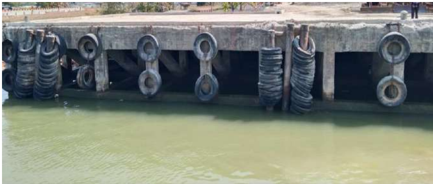
เสาหลักกันกระแทกและชุดล้อย่างกันกระแทก
