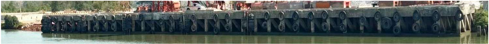
ภาพรวมอุปกรณ์ป้องกันการกระแทกจากเรือสินค้าหน้าท่า
