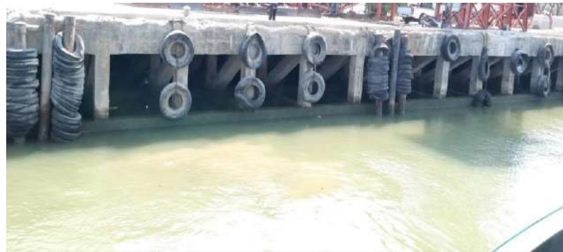
เสาหลักกันกระแทกและชุดล้อย่างกันกระแทก
