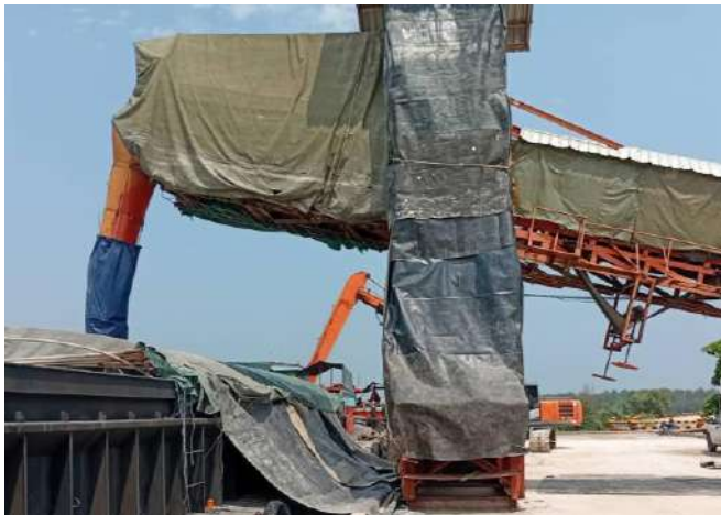
การปิดคลุมด้วยผ้าใบและตาข่ายกันฝุ่นตลอดแนวสายพาน ปลายปล่องปล่อยสินค้าและเสารับโครงสร้างอย่างมิดชิด
