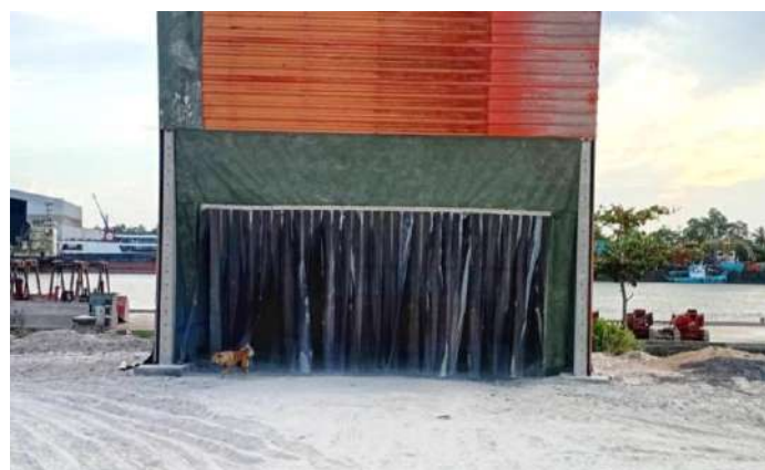
การติดตั้งม่านพลาสติกแบบหนาเพื่อป้องกันฝุ่นบริเวณช่องทางเข้าออกรถบรรทุก
